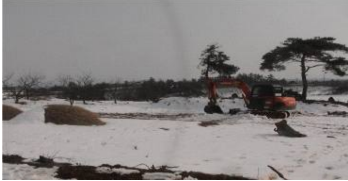
살처분 저장조 시설전 트럭평탄작업
